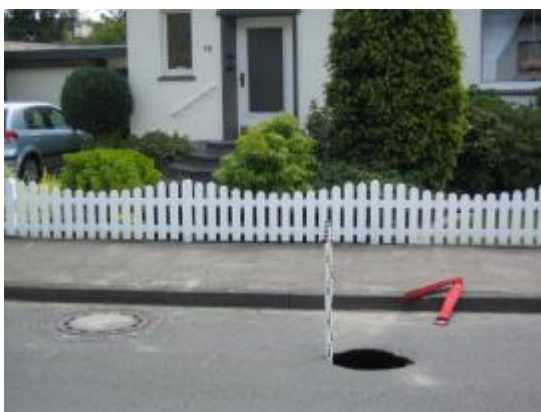
Rietberg, Kochstraße: Juli 2008 Einbruch der Fahrbahndecke über Regenwasserkanal : ca. 50 cm Durchmesser
