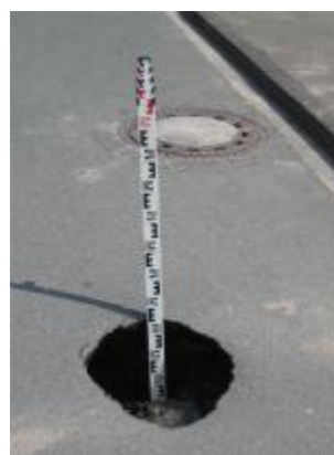
Rietberg, Kochstraße: Juli 2008 Einbruch der Fahrbahndecke über Regenwasserkanal : ca. 50 cm Durchmesser
